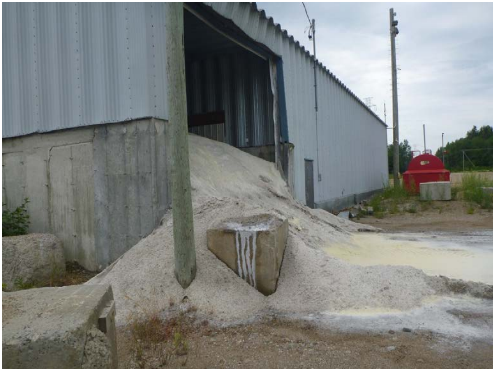
Photo 28, point 6 : entrepôt étant la source des nombreuses taches de sels de voirie sur le site (8 au 19 juillet 2013)
