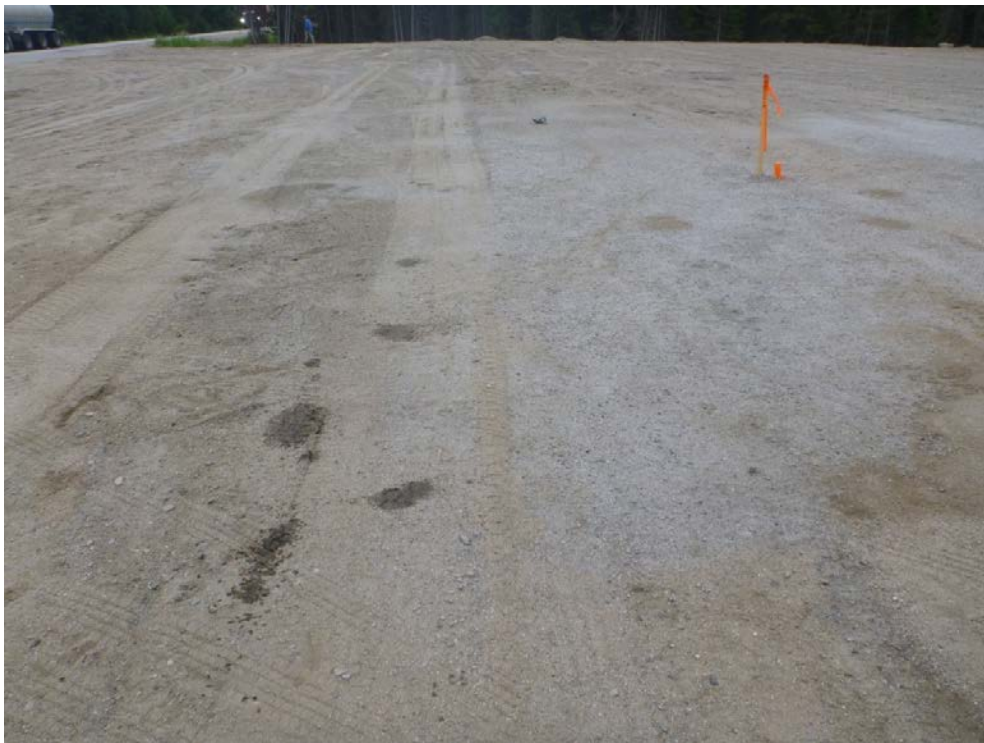
Photo 12, point 14 : taches d'hydrocarbures pétroliers (huile) au sol dans une aire d'arrêts en bordure de la route (8 au 19 juillet 2013)
