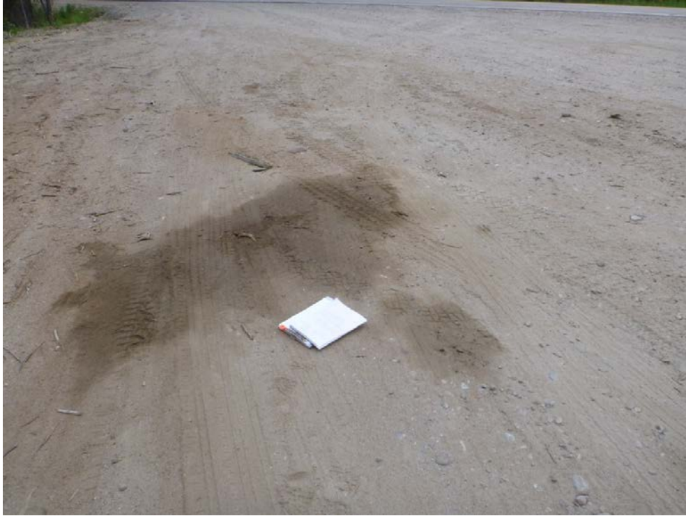
Photo 3, 49°48'00" N -68°44'08"O, 340 mètre au nord du segment 24, dans l'accotement de la route : tache d'hydrocarbures pétroliers (huile) au sol (8 au 19 juillet 2013)
